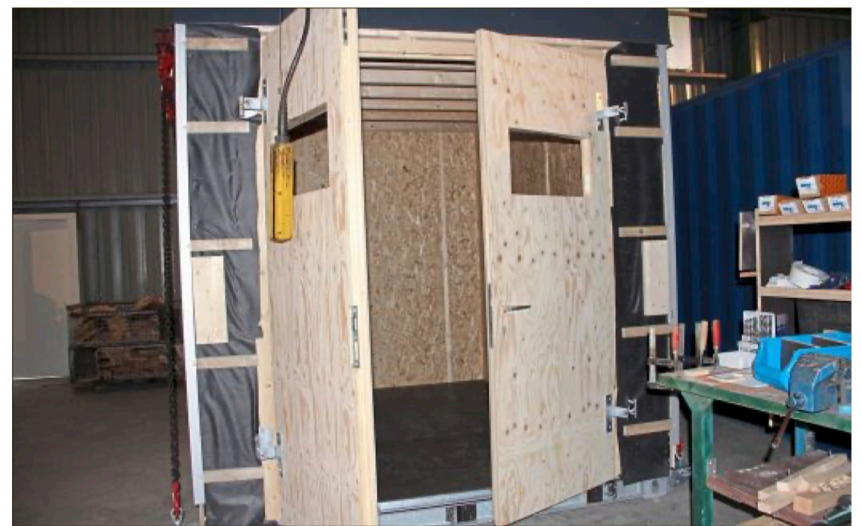
Neben einem Container als Basis wird ein mobiler Nebenraum auch mit Holzständersystem gebaut.
